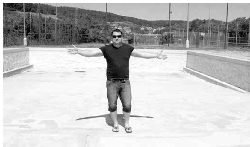
Starosta Pašovic Vlastimil Řežníček uvnitř bazénu, který se už tento týden naplní vodou. Minulý týden se natíralo dno, na tu nejdůležitější opravu, na utěsnění vany, se stále musí čekat. Obec nemá dostatek peněz na rekonstrukci. FOTO: ARA
